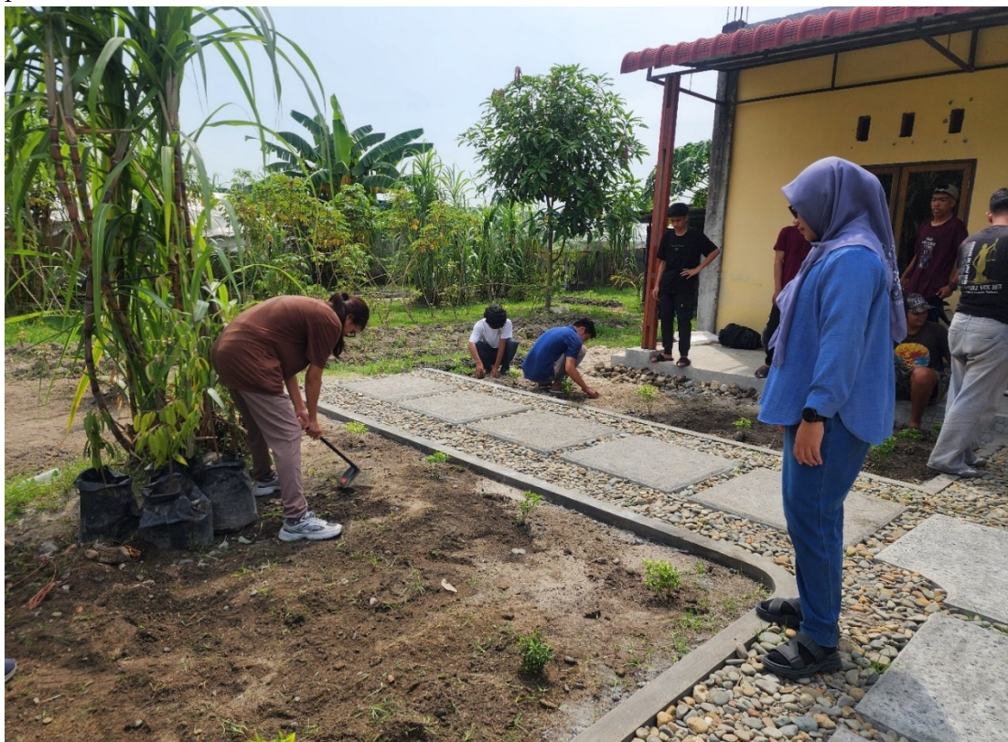
Gambar 3. Pelaksanaan Pembangunan Perkerasan Jalan Resap Air di Kampong Jatirejo
